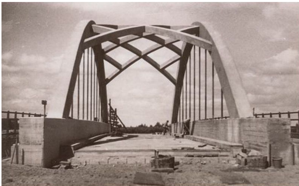
De 'Witte Brug' over de Rijksweg bij Sliedrecht in aanbouw.
