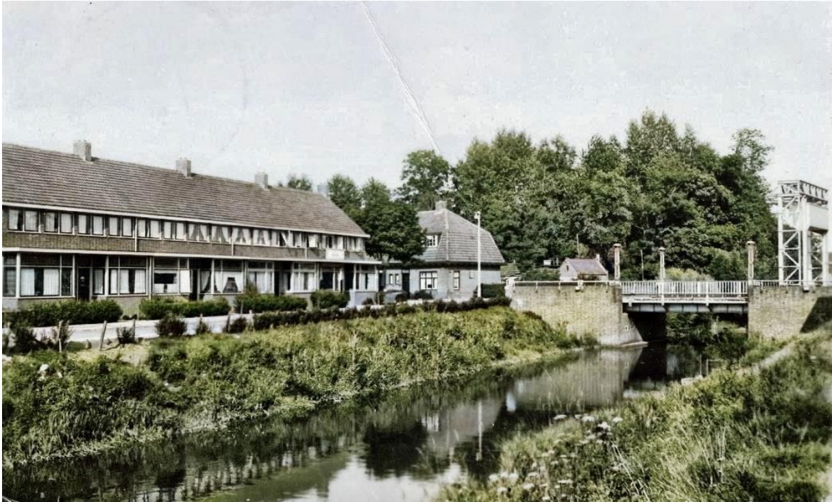
Kleindiepstraat met rechts de vroegere Westerbrug ..
